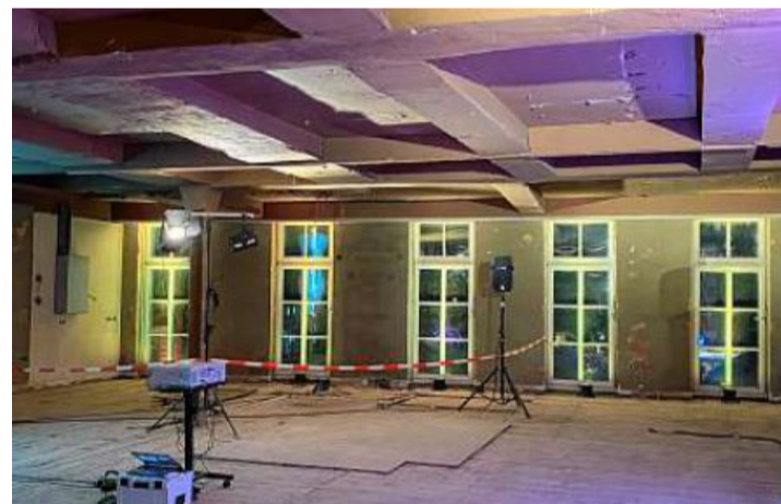
Früher der Ballsaal des „Gmünder Hof“: Er soll unter anderem als Trausaal genutzt werden.
