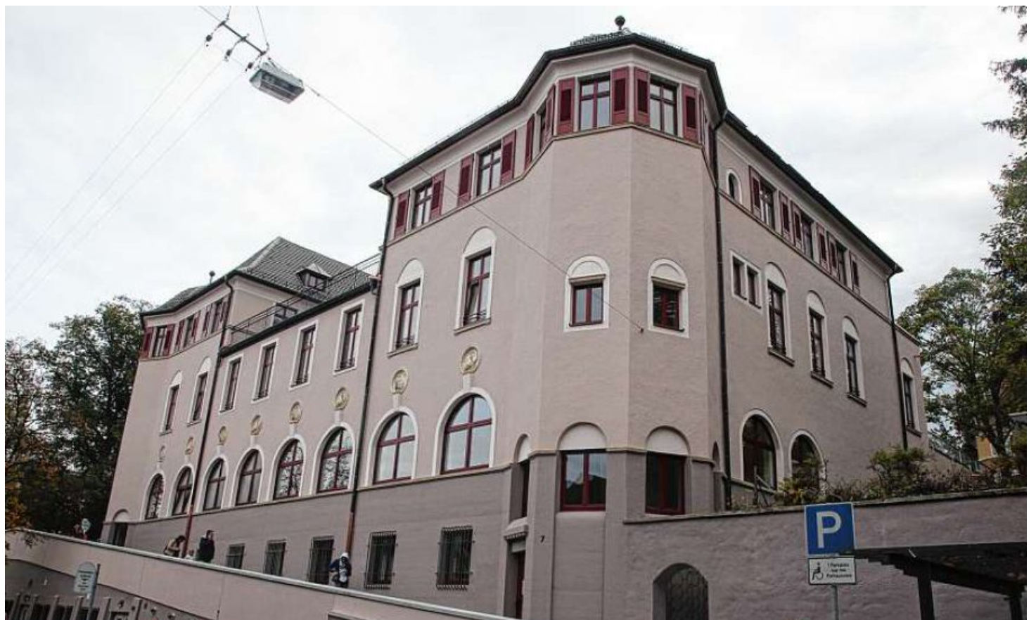
Drei Jahre lang wurde es saniert, am Wochenende eingeweiht: das Augustinus-Gemeindehaus in der Gemeindehausstraße in Schwäbisch Gmünd.
