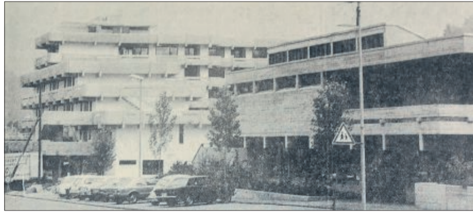
Ein Foto aus der gleichen Perspektive, aber aufgenommen vor genau 50 Jahren, als am Paul-Gerhardt-Haus (links) die letzten Arbeiten im Gange waren. Die „Brücke“, das evangelische Gemeindezentrum, ist dem Neubau von Wohnhäusern gewichen. Foto: sta
